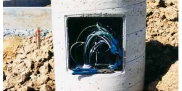
d'autant que 30 %. Pour une plus grande souplesse, les couvercles convexes des boîtes J-Box ont des emplacements pour installer des prises et des couvercles étanches aux intempéries. Quant à la maintenance, elle s'en trouve facilitée. Les luminaires peuvent être protégés à partir de la base du poteau et, si nécessaire, les poteaux peuvent même être enlevés et remplacés au milieu du circuit sans que l'éclairage complet n'en soit affecté.
